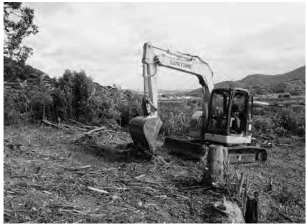
写真1 バックホウによる表土除去作業
