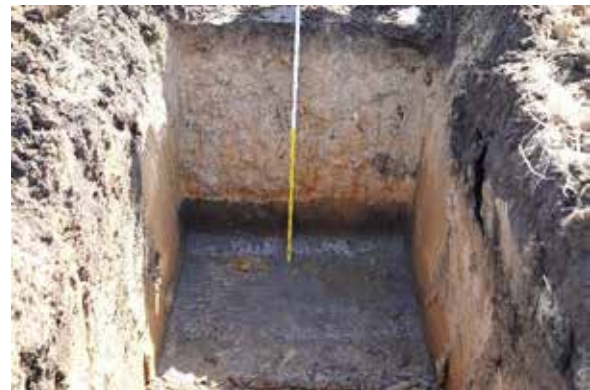
試掘坑 25 完掘状況
