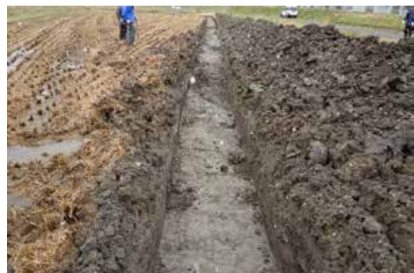
試掘トレンチ 11 完掘状況
