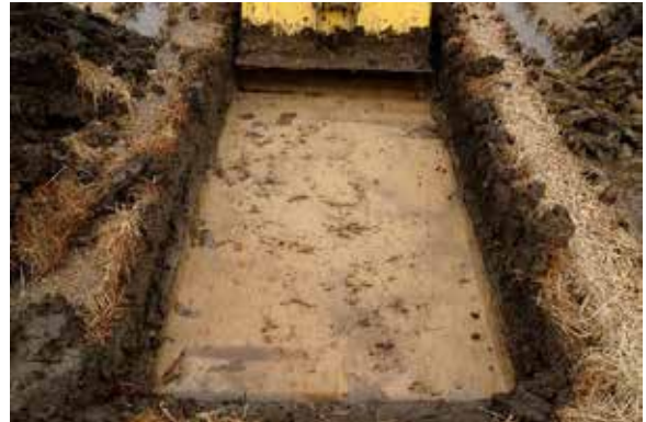
試掘坑 5 完掘状況
