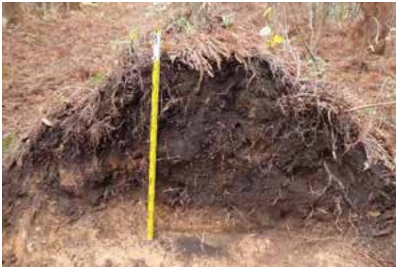
試掘坑 1 4 完掘状況
