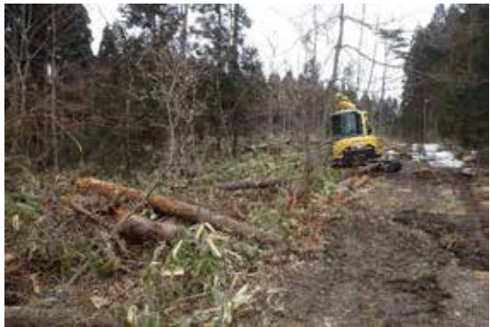
調査地点 2 (鉄塔No. 1 5) 近景
