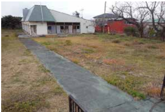
調査対象地近景
