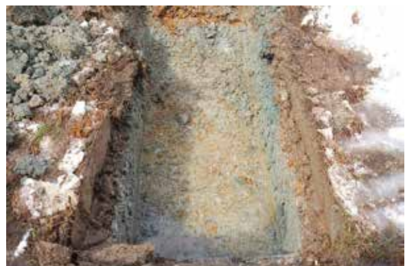
試掘坑 5 完掘状況
