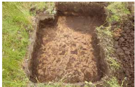
試掘坑 1 完掘状況
