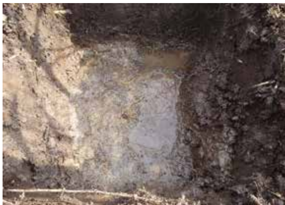
試掘坑 3 完掘状況
