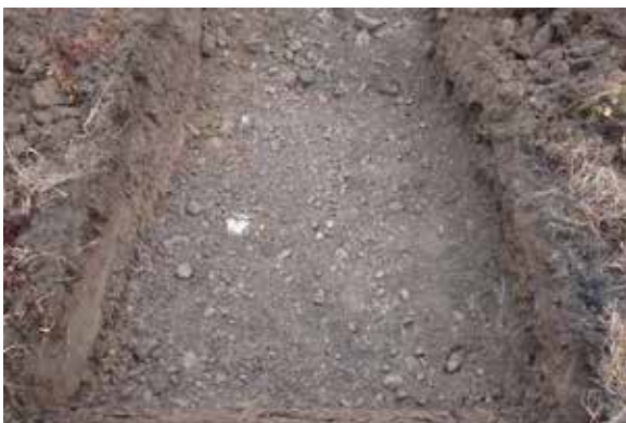
試掘坑 1 0 完掘状況
