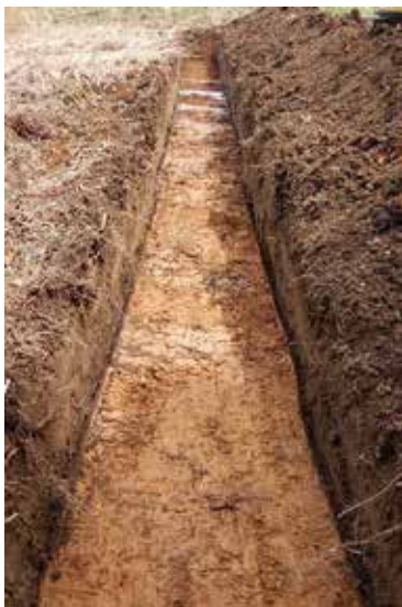
試掘トレンチ3 完掘状況
