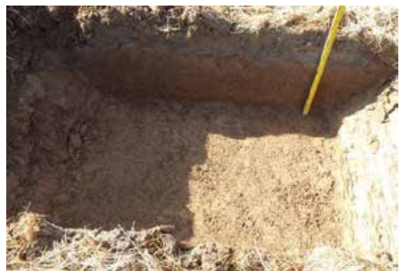
試掘坑 2 完掘状況
