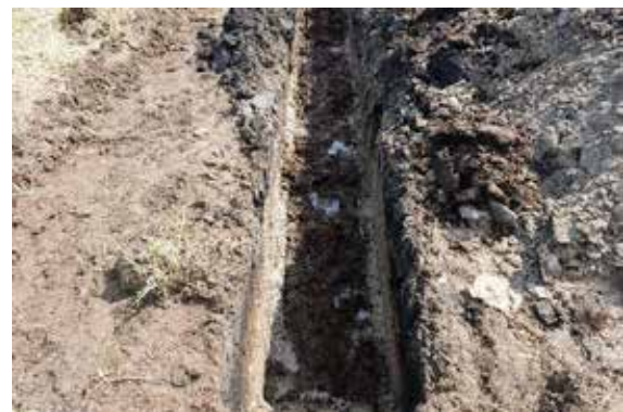
調査地点 5 試掘トレンチ 1 完掘状況
