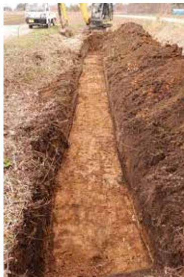
試掘トレンチ4 完掘状況
