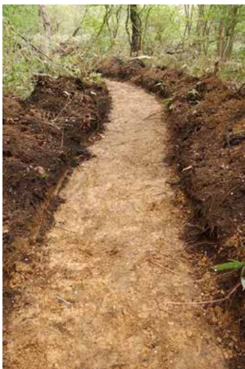
調査対象地 2 試掘トレンチ 1 完掘状況
