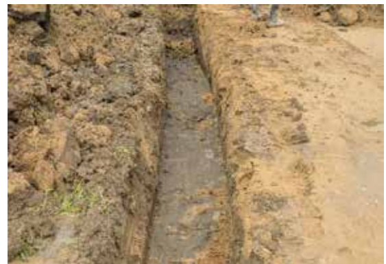
調査地点 2 試掘トレンチ 1 完掘状況
