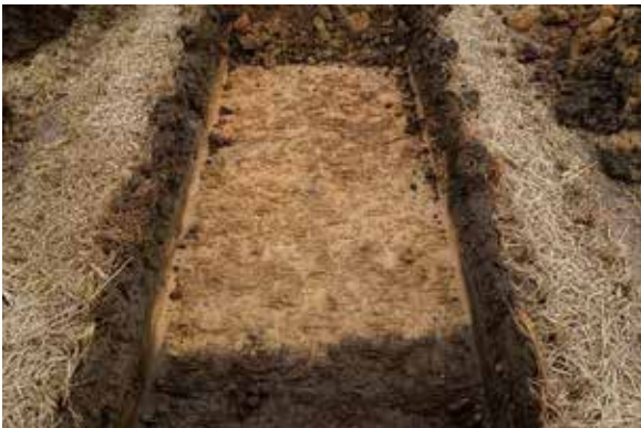
試掘坑 9 完掘状況
