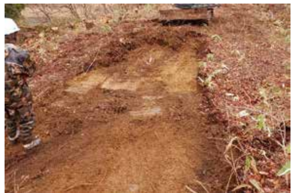
調査地点 3 試掘坑 2 調査状況
