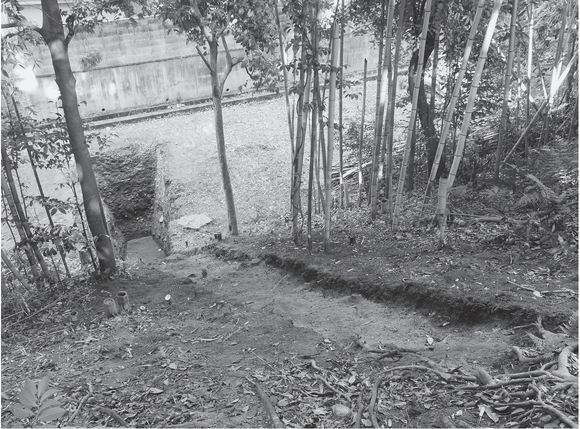
1 24次 2区土塁検出状況（南東から）
