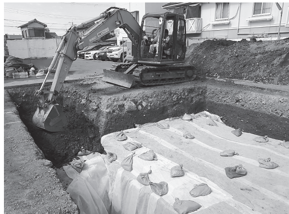
図11 25次 埋め戻し風景（北東から）
