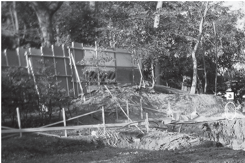
図19 第1トレンチ該当部近景（南西から・平成26年（2014）1月22日）
