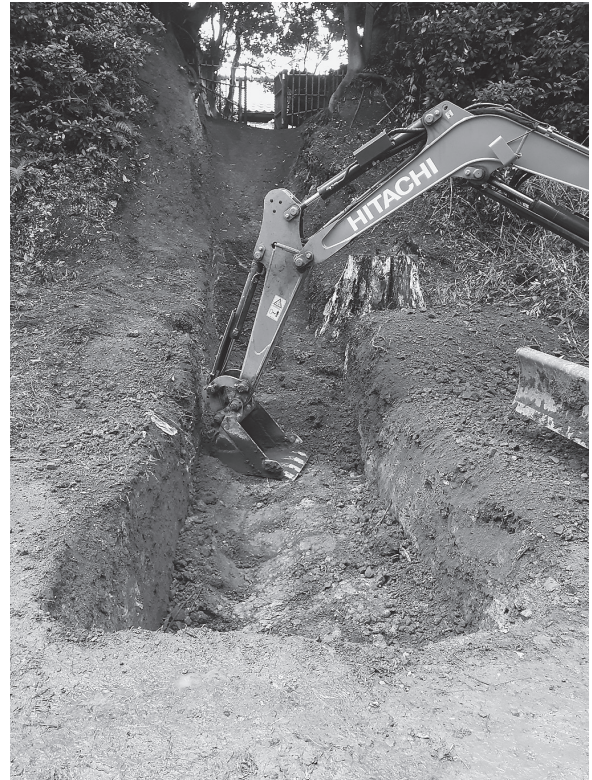
図3 24次 埋め戻し風景（北から）
