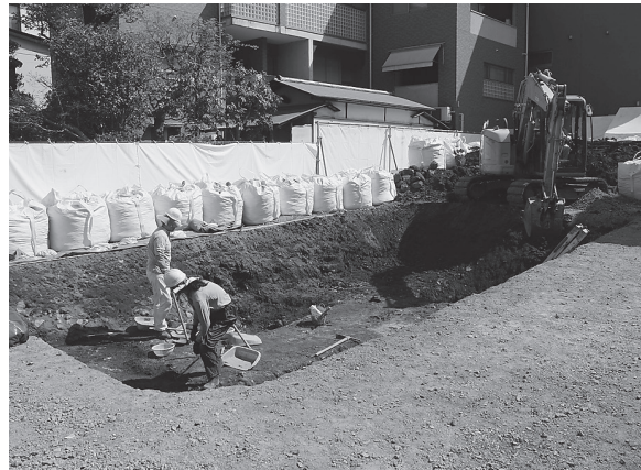
図4 作業風景 (北西から)
