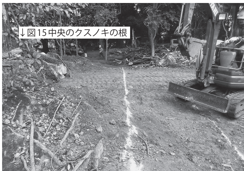
図16 第1トレンチa区塩ビ管SX101掘削開始（西から・平成25年（2013）12月13日）
