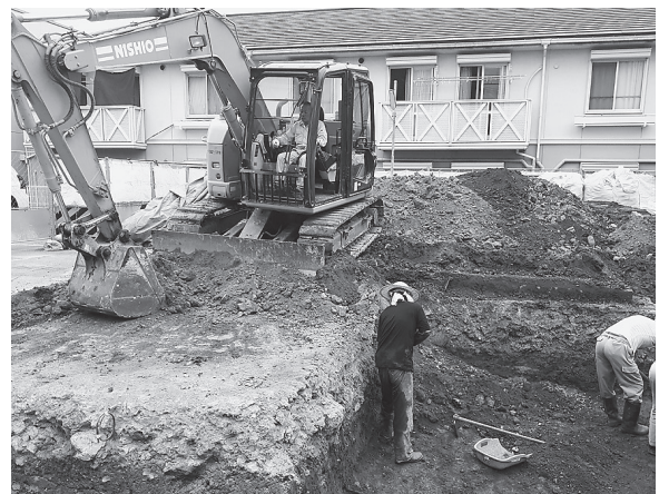
図7 25次 重機掘削風景（東から）
