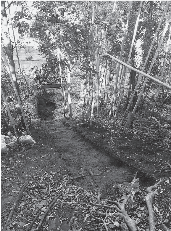
図2 24次 重機掘削風景（南西から）
