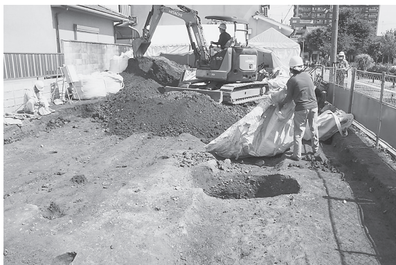
図5 埋戻し状況 (南から)
