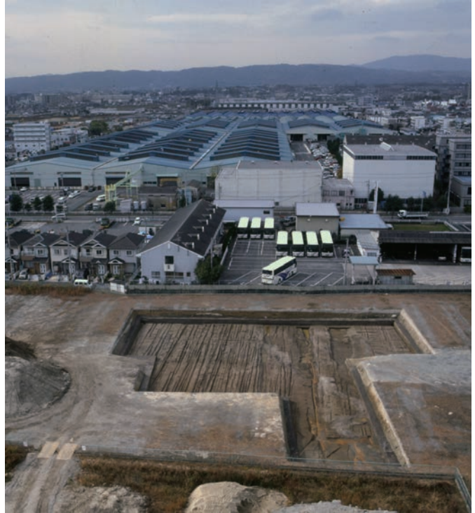
図5 市 HJ 第 538 次調査地全景 (東から、中央奥の白い建物部分周辺が今回の調査地)
