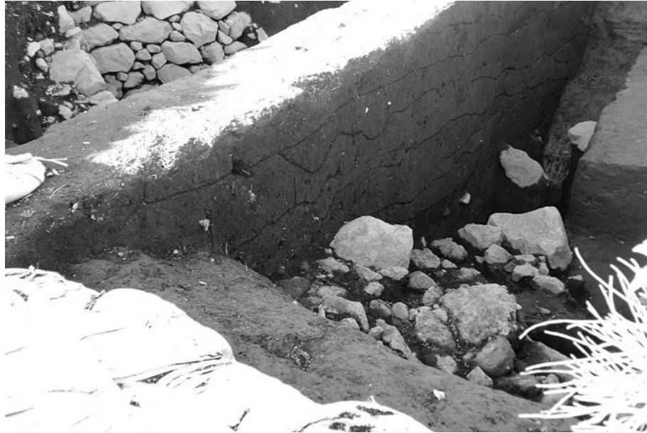
二ノ丸空堀 (東) 石垣 セクション (南東から)
