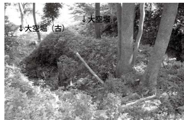
写真 49 大空堀 TRE1 調査前 (北西から)
