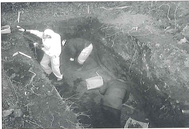
1トレンチ調査状況
