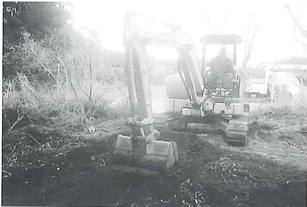
4トレンチ調査状況
