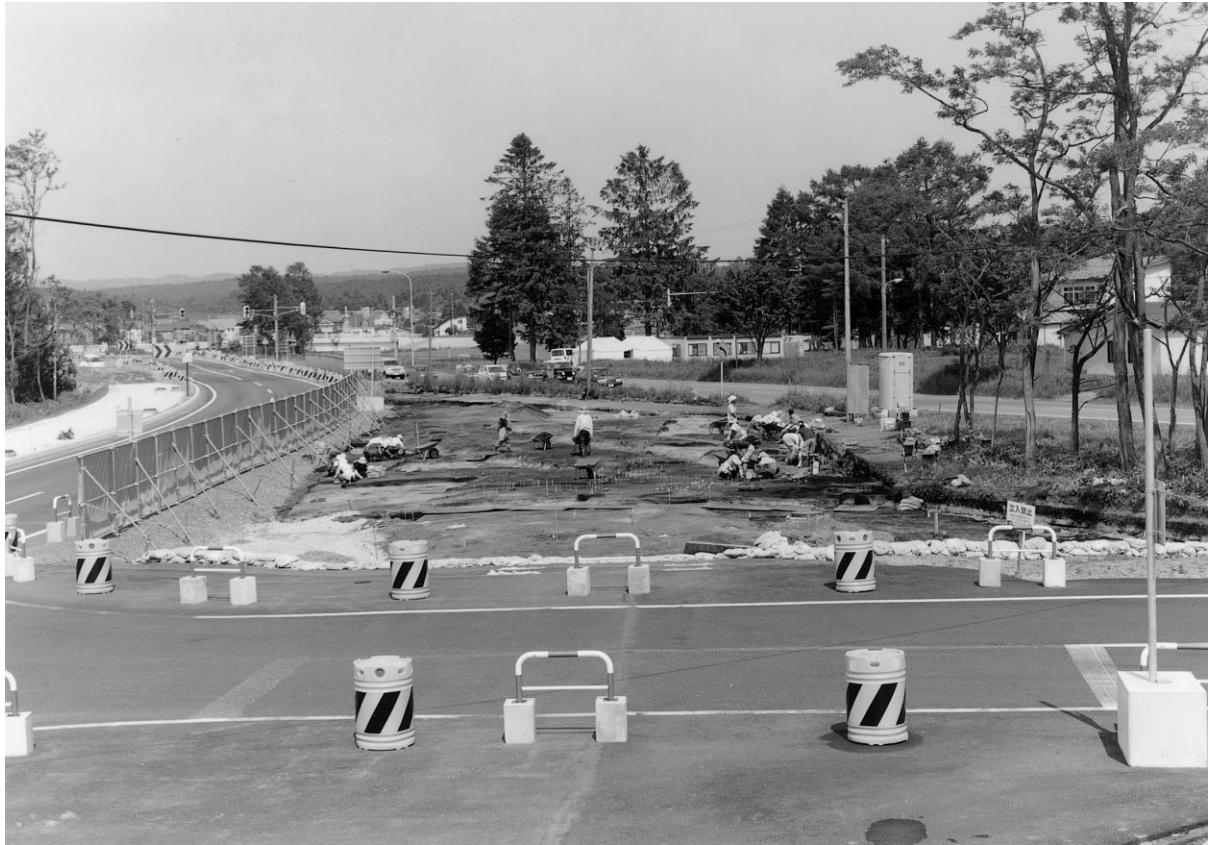
調査区南東側 作業状況 (W→)
