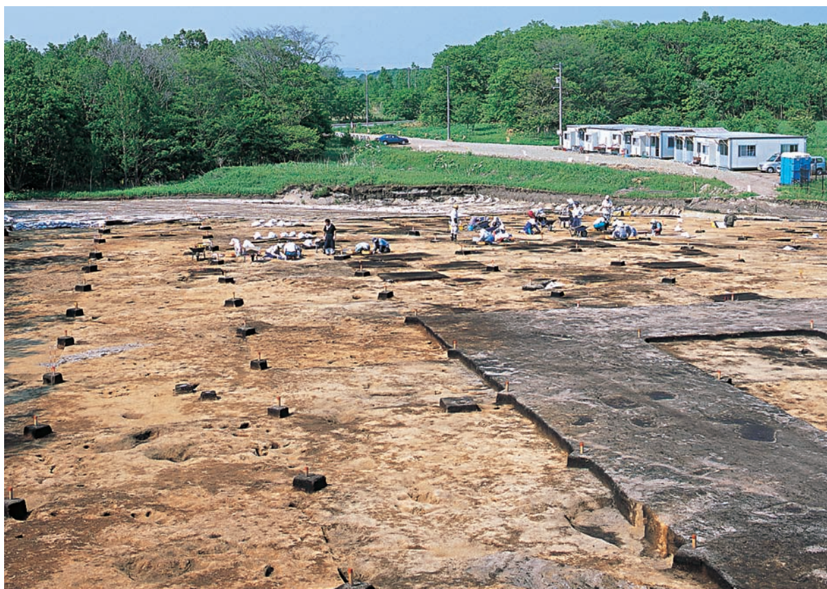
Ⅲ層調査状況
