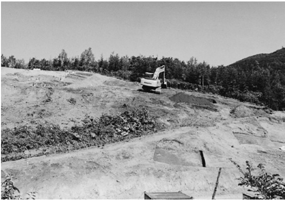
1 重機調査(斜面部、南東から)
