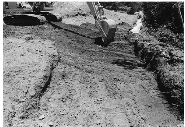
4 重機調査(中位部、南西から)
