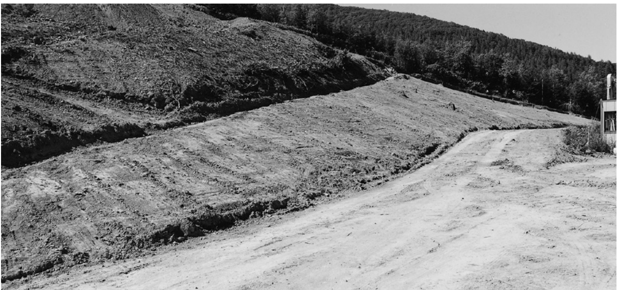
3 斜面部調査終了(南から)
