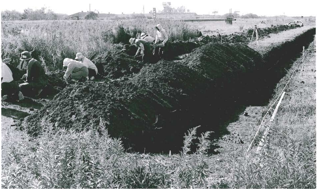
調査風景 E→W
