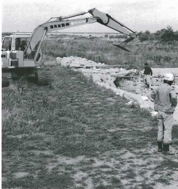
大型土囊除去作業 SW→NE
