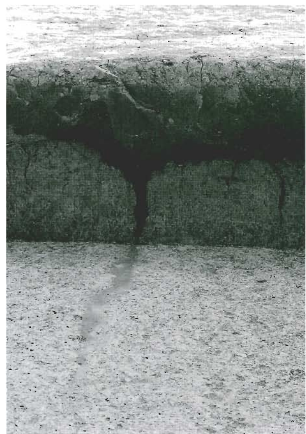
断面 (68-172) NE → SW
