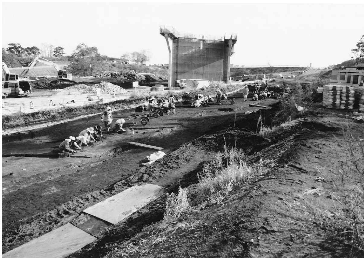
1. 町道部分調査風景（西から）
