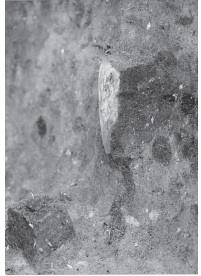
同左拡大 NE→SW
