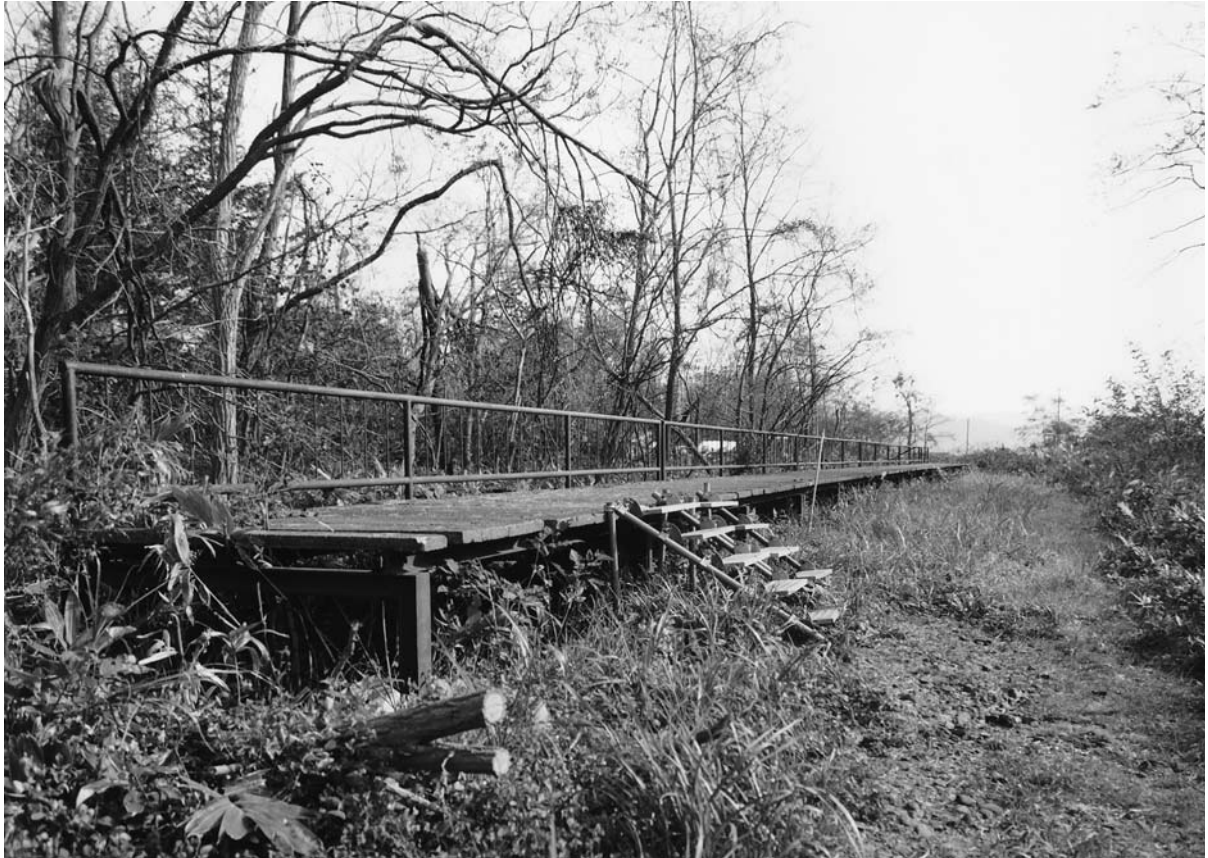
1 岩内線西前田駅プラットホーム跡
