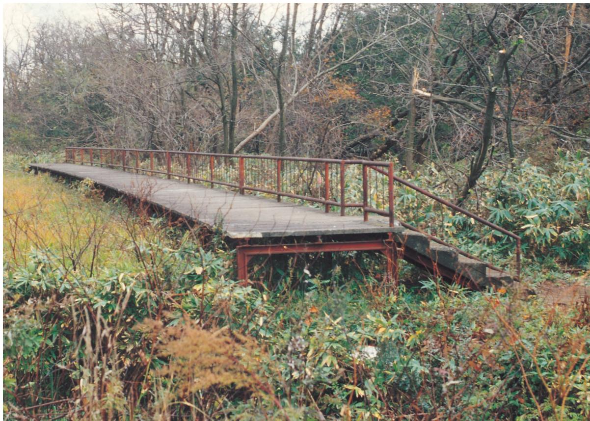
2 岩内線西前田駅プラットホーム跡
