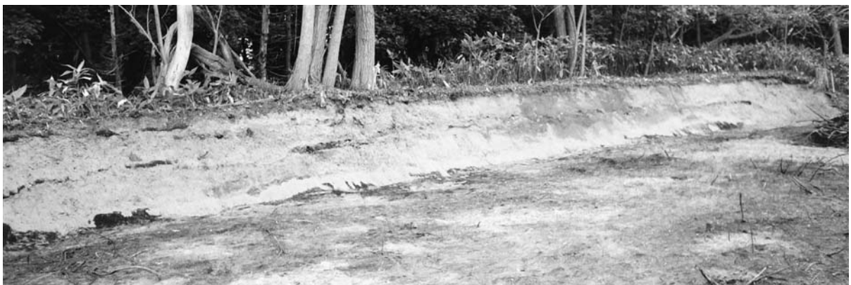
3 茅沼炭鉱鉄道路盤土土層断面
