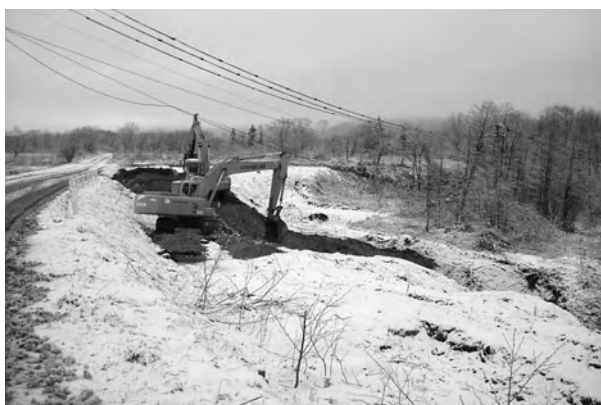
3. 表土除去① (SE→)
