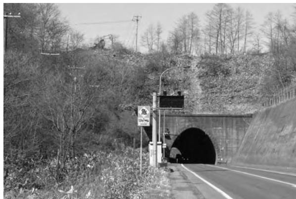
2. 虎杖浜隧道から見た遺跡 (E→)
