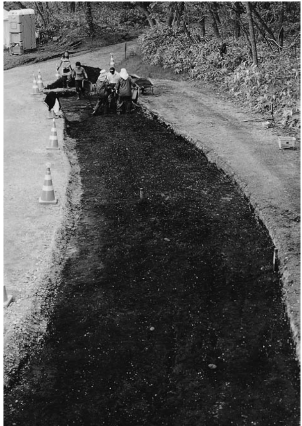
4. 表土等除去後の状況〔北半〕(東から)
