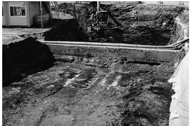
2. 表土除去(南東から)
