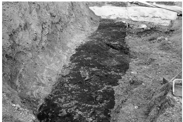
6. 表土等除去後〔⑥区〕(北西から)
