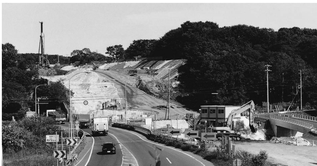
2. ポンアヨロ 4 遺跡近景(西から)
