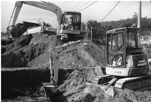
1. 表土除去(南東から)
