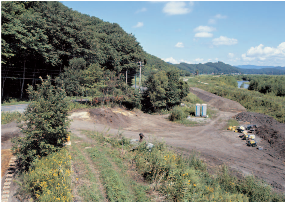
3 北側調査区全景
