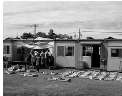
土壌水洗作業状況 1
