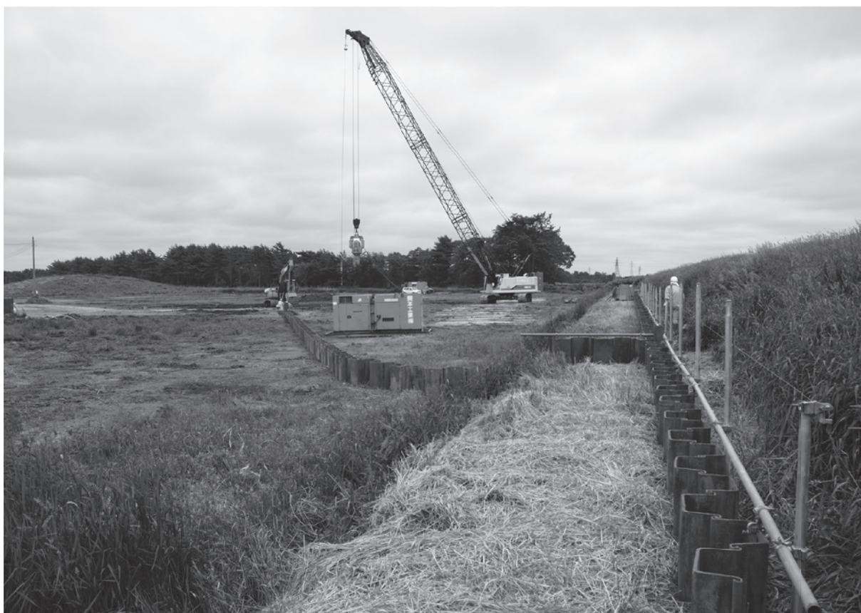
2 鋼矢板打設（平成28年度）
