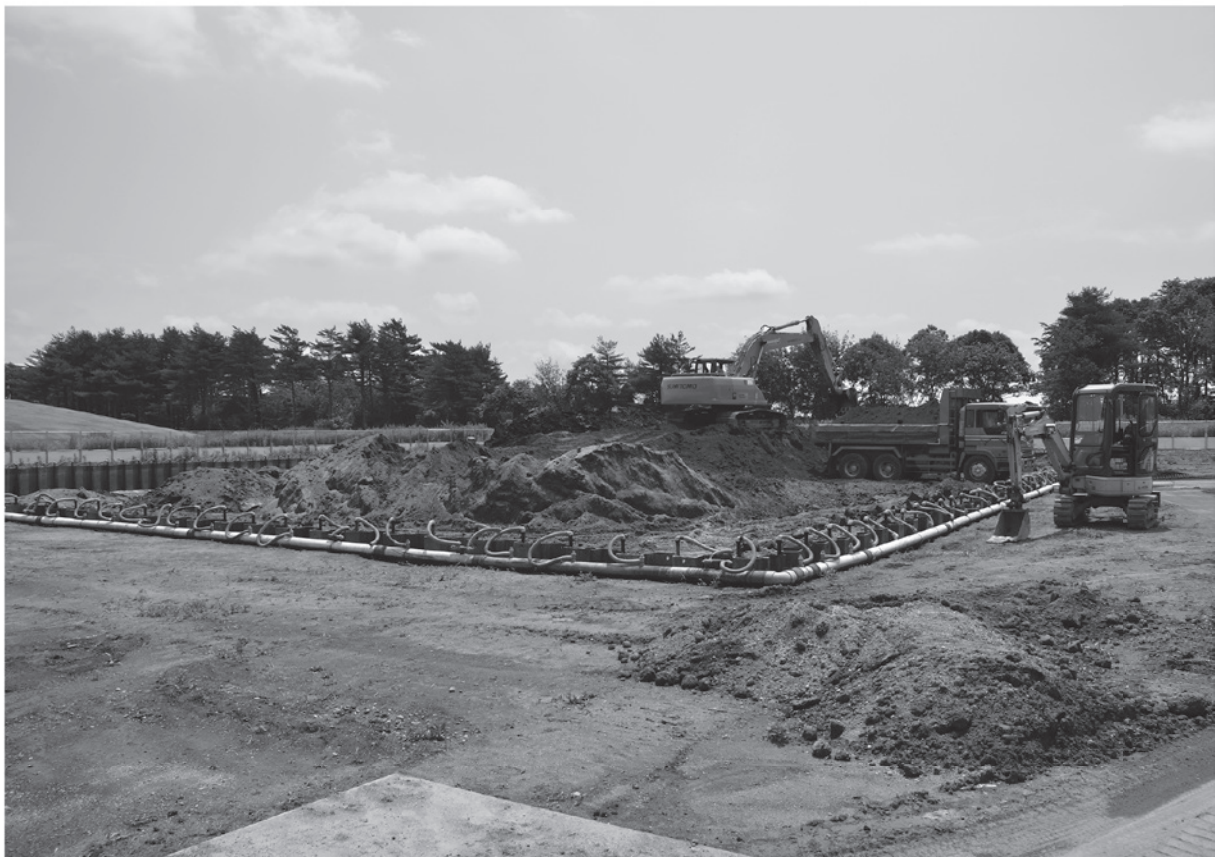
2 表土除去（平成26年度）
