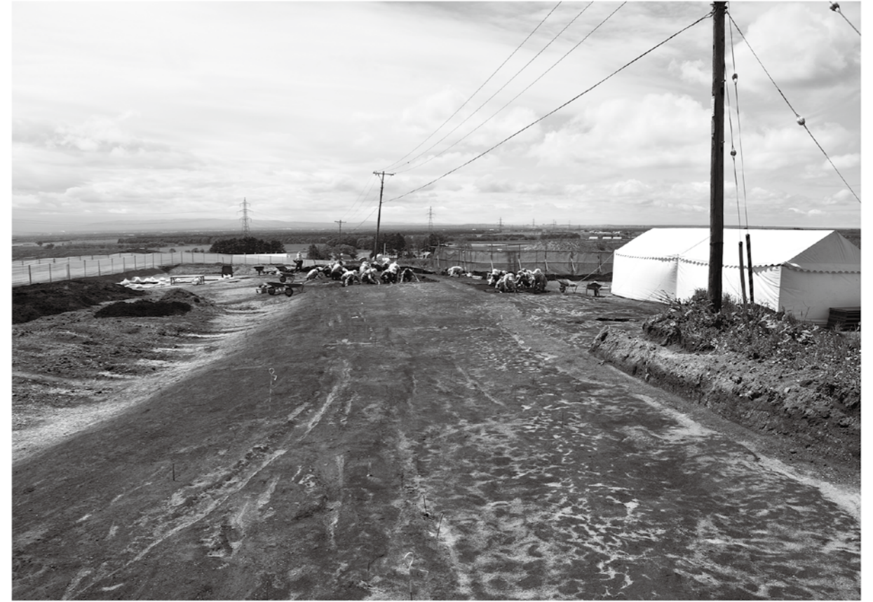
1 農道下表土除去後
