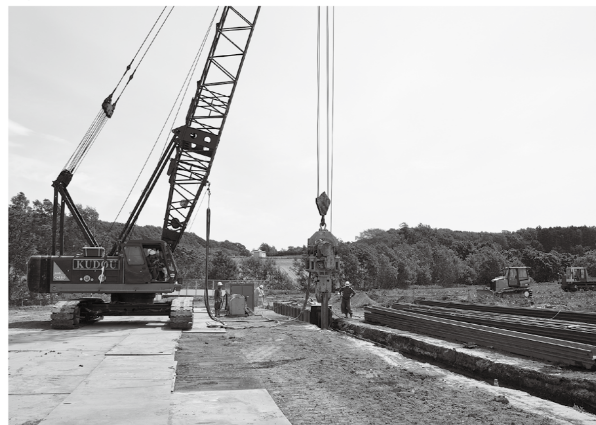
2 鋼矢板打設工事（平成26年度）
