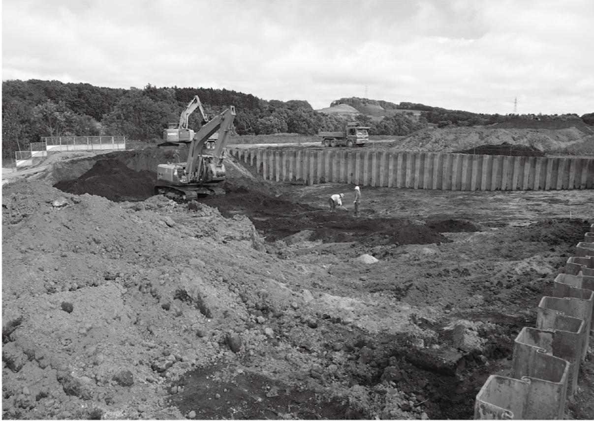
1 表土除去作業(平成26年度)
