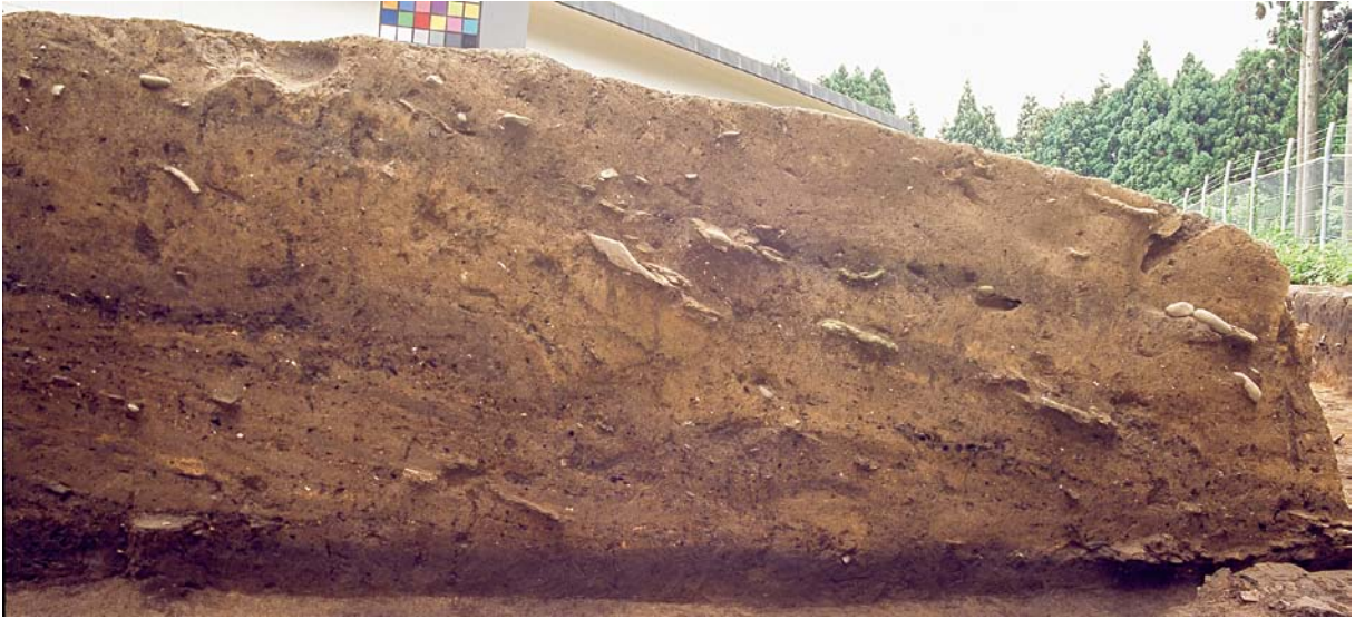
B、C' 盛土 土層断面 (F2 区) 北西から
