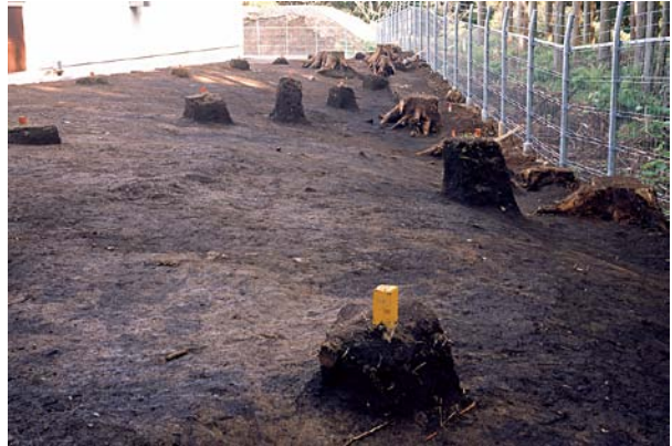
平成23年度 盛土上面 北西から
