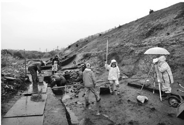
降雨中の測量作業
