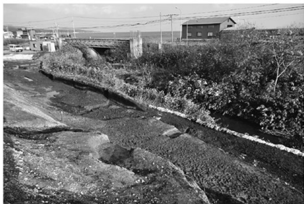
調査終了状況
