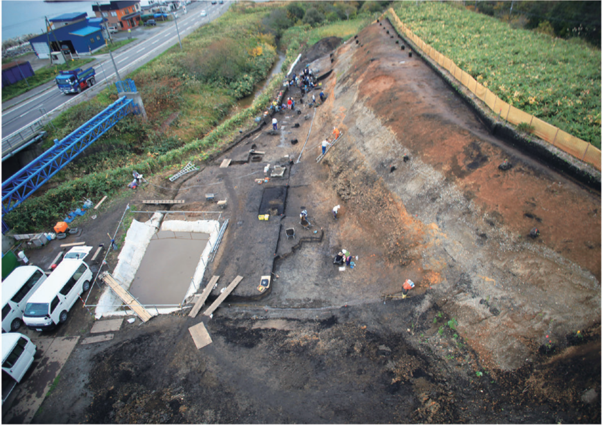
大平遺跡調査状況 北東から
