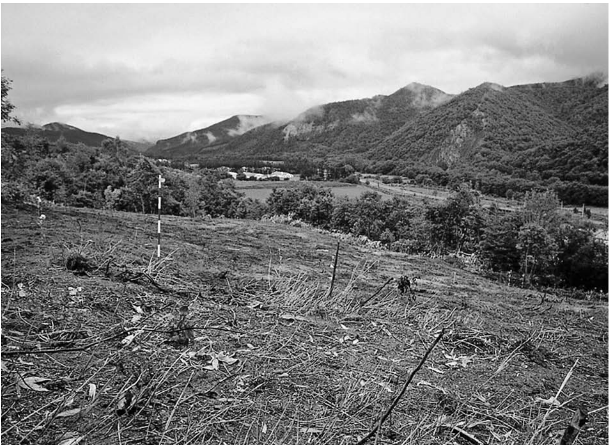
2 F区表土除去後の状況(西から)
