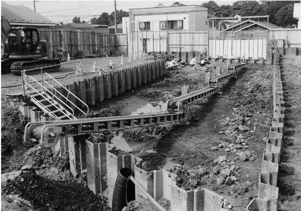
ベルトコンベアー設置
