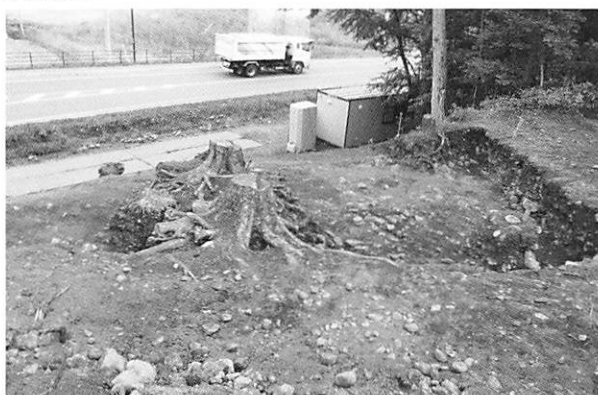
1 平坦部調査状況（西から）
