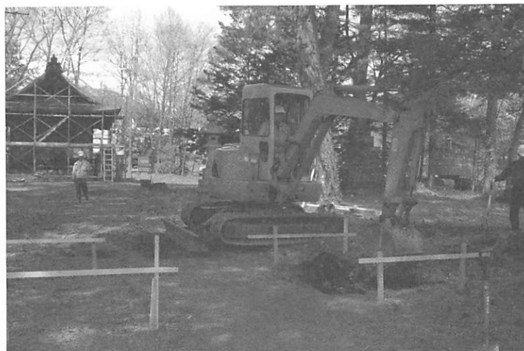
04 鳥居新設地・表土の掘削状況
