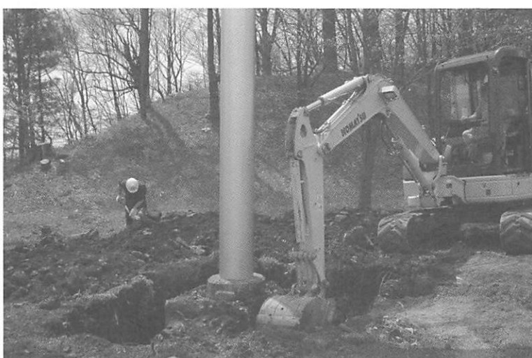
03 旧鳥居の掘り方埋土の掘削状況
