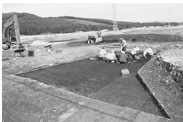
5 鉄塔下 T65・66区調査状況（南から）
