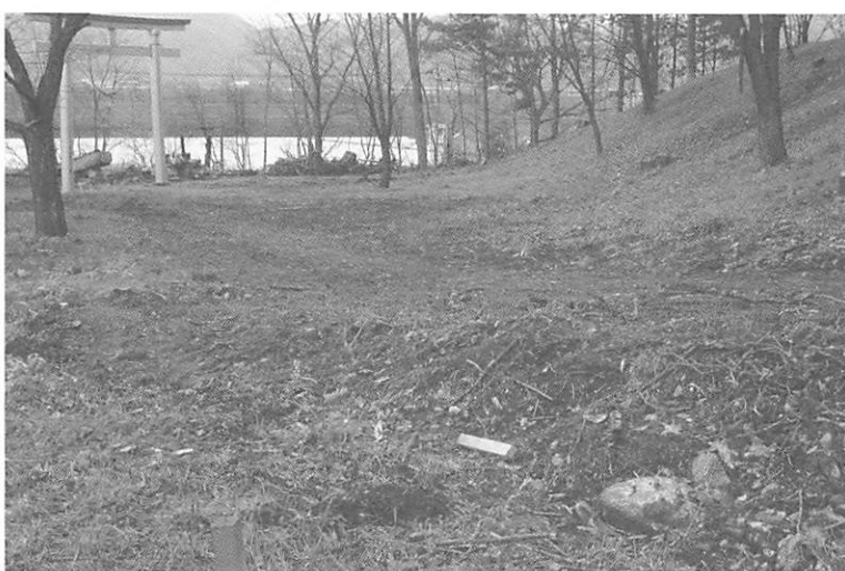
02 工事着工前の状況
