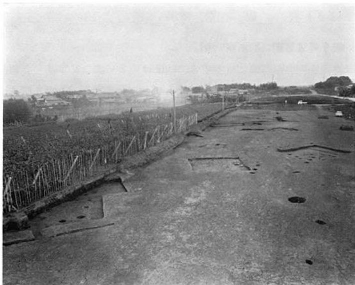
Fig. 58 野口遺跡北半遺構全景
