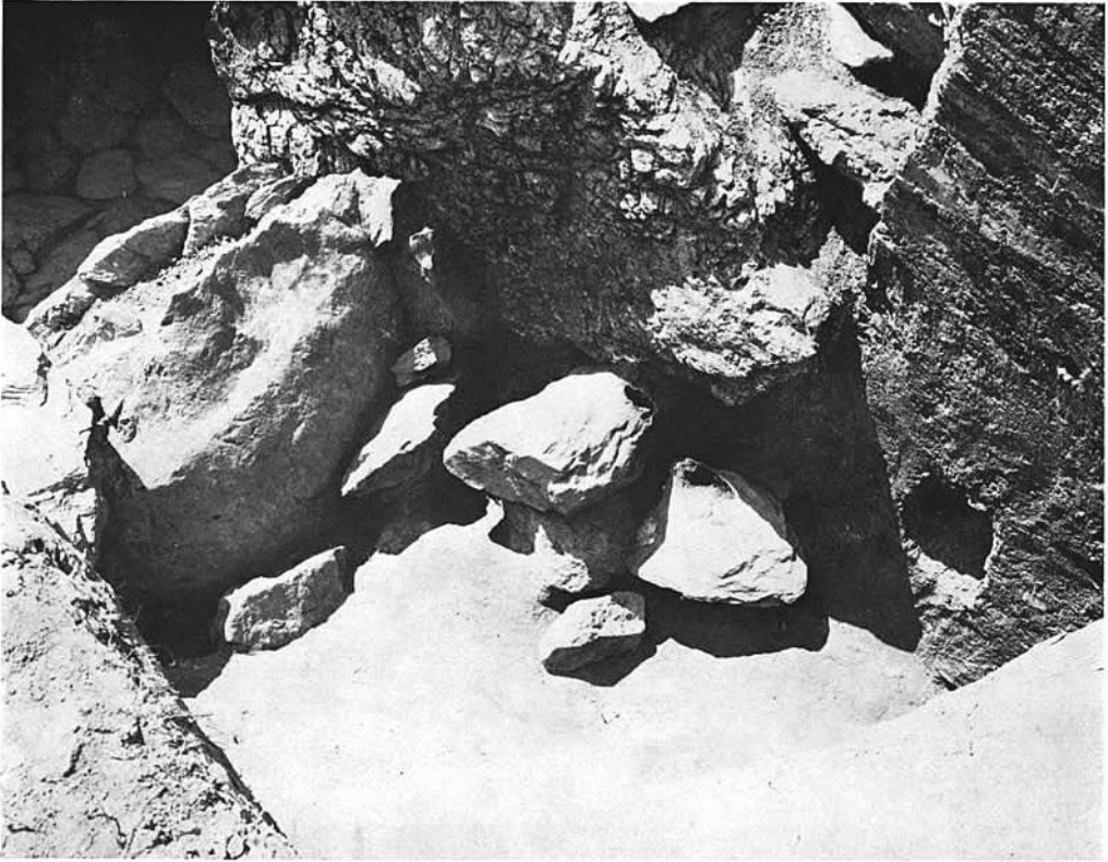
1. 乙植木 4 号墳右袖石基部根締状態
