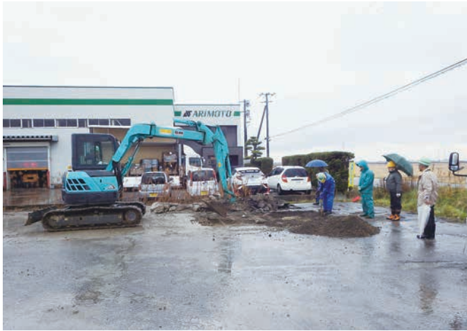
中沢遺跡 1 トレンチ調査風景（南東から）
