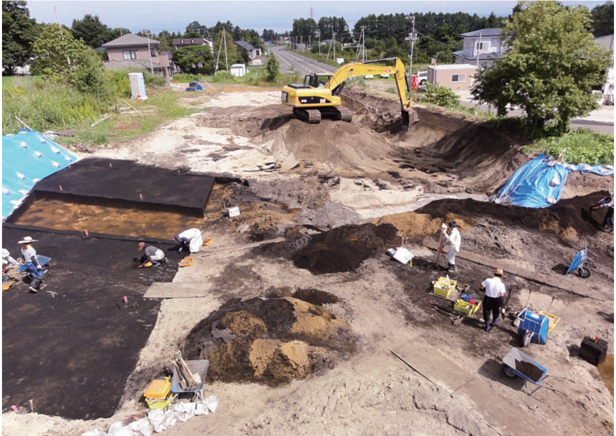
⑤地区表土除去
