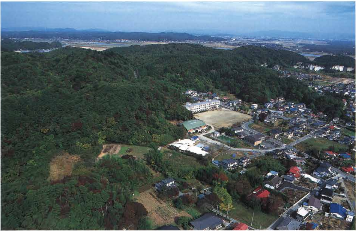
1. 亀岡遺跡全景（南西上空から）〔フィルムE1799〕
