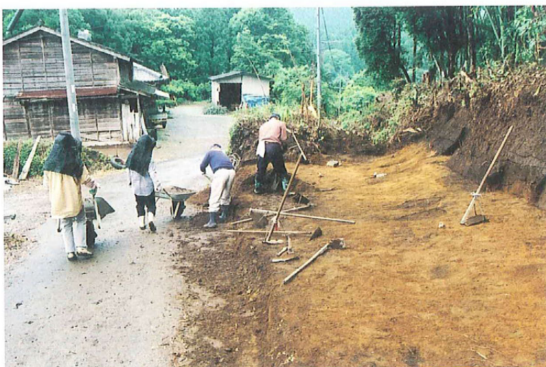
7 中世遺構検出作業風景
