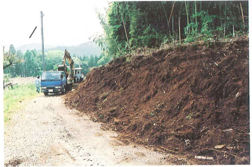
2 重機による表土剥ぎ作業
