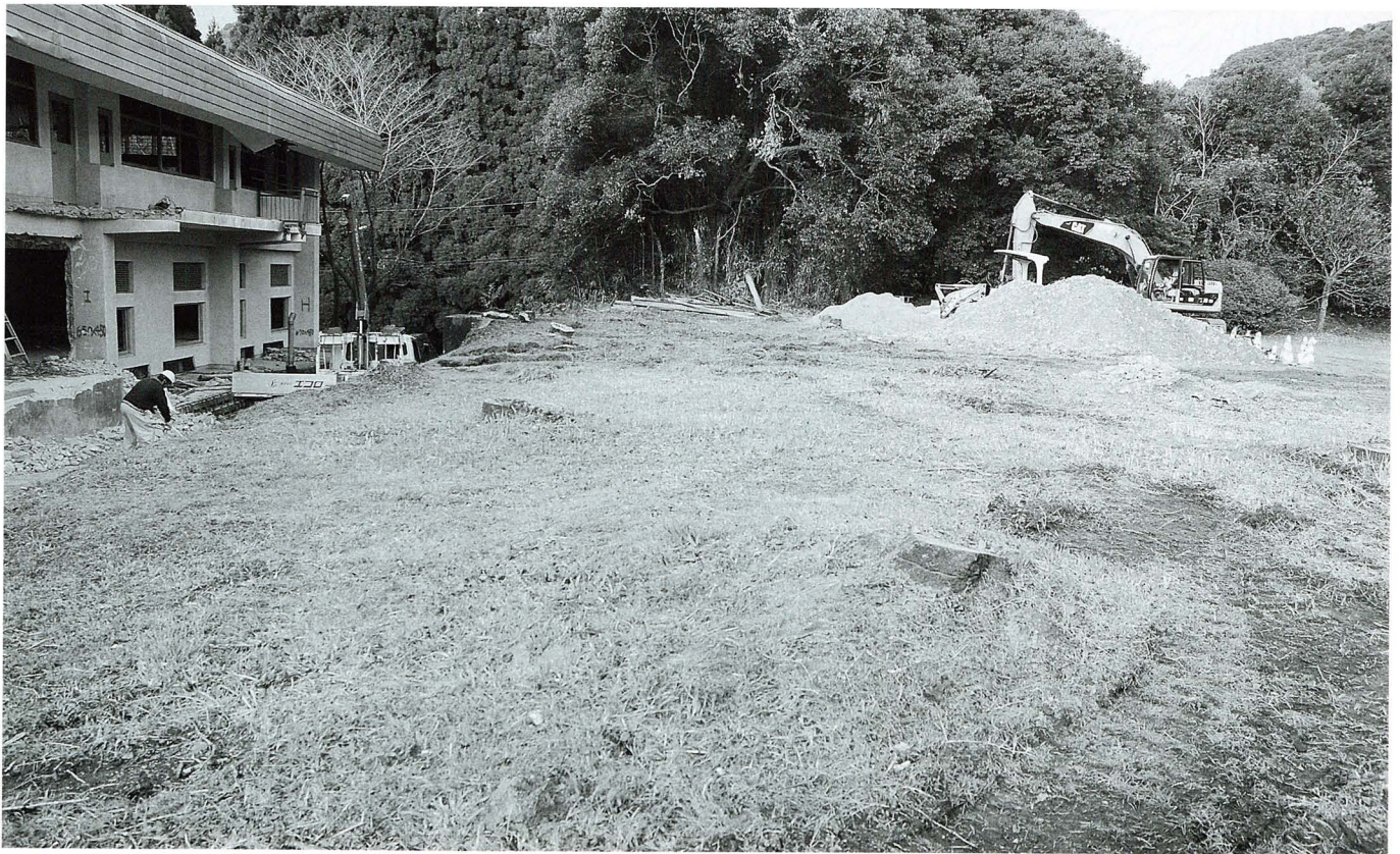
写真図版9 樹木抜根作業予定地全景
