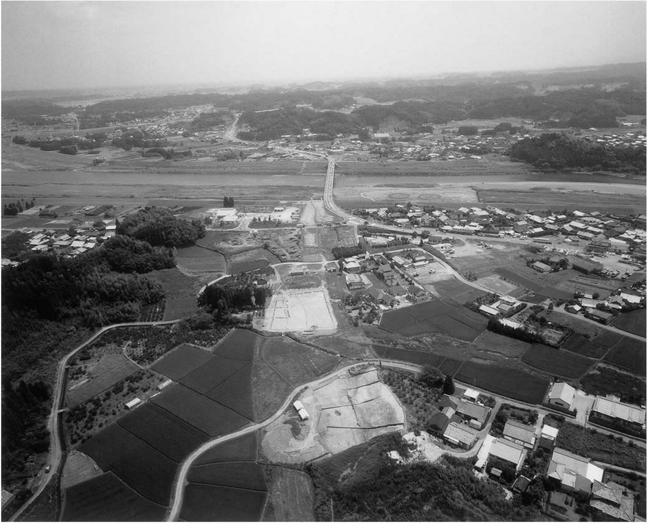
調査区遠景（手前からB区、A区、奥は大淀川）
