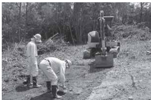
調査風景(2011年4月)
