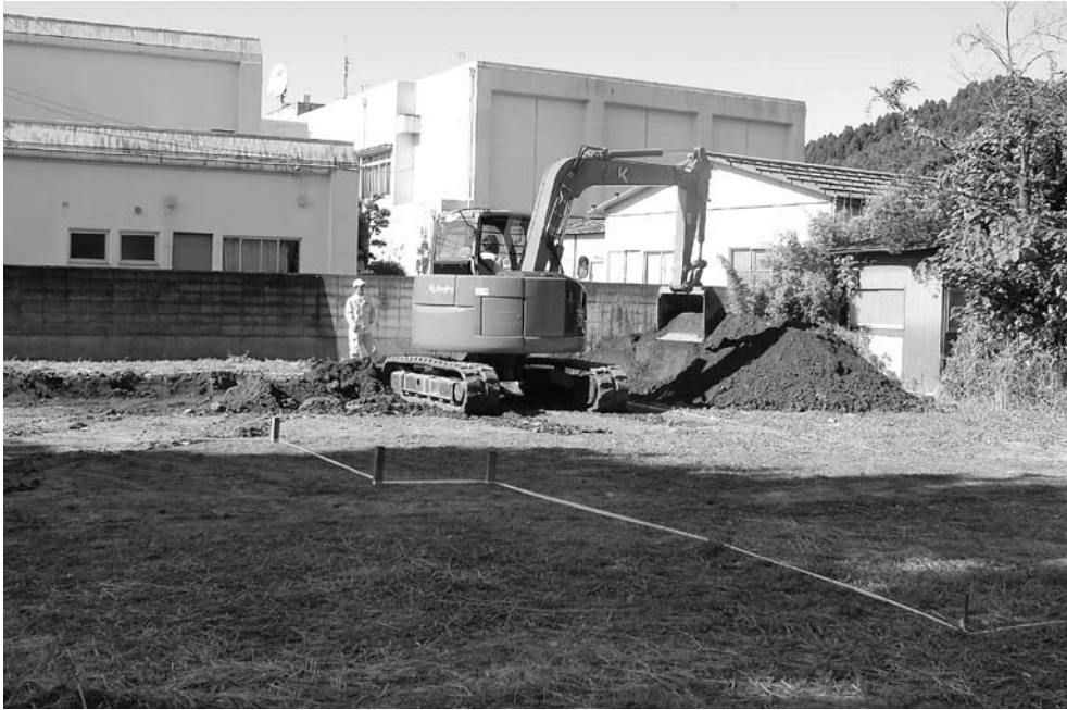
図版4 表土剥ぎ作業風景
