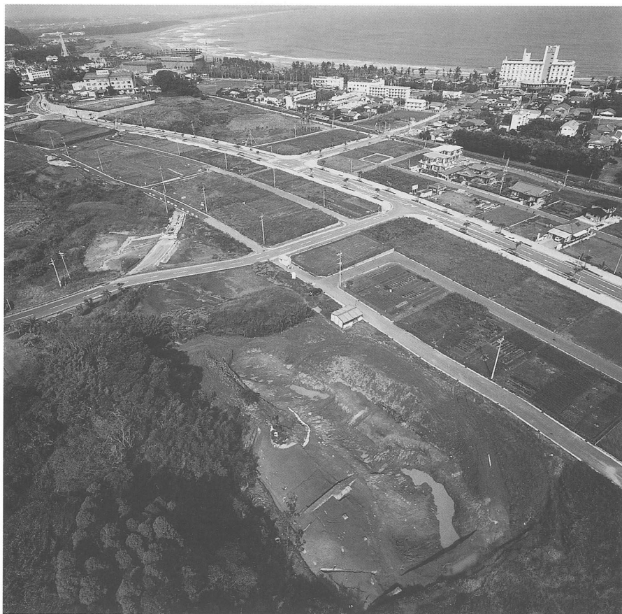
D・E区遠景（南より）
