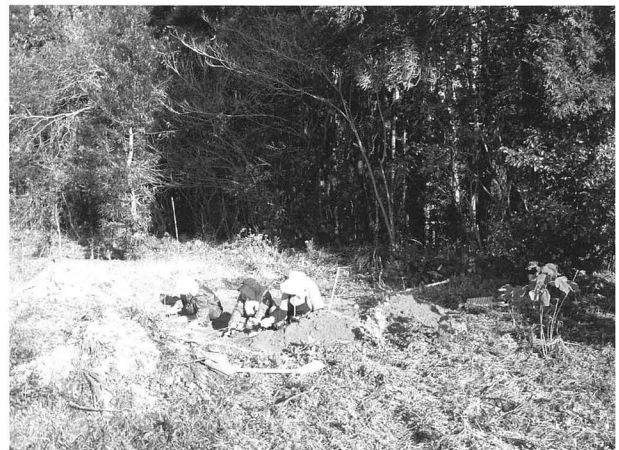
掘削作業風景
