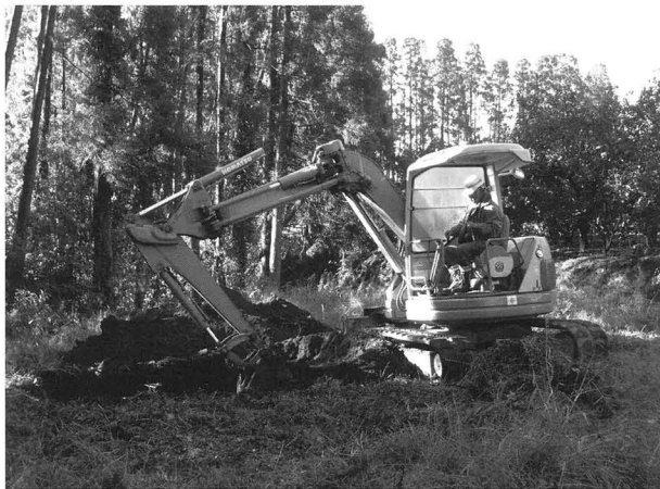
重機による表土剥ぎ
