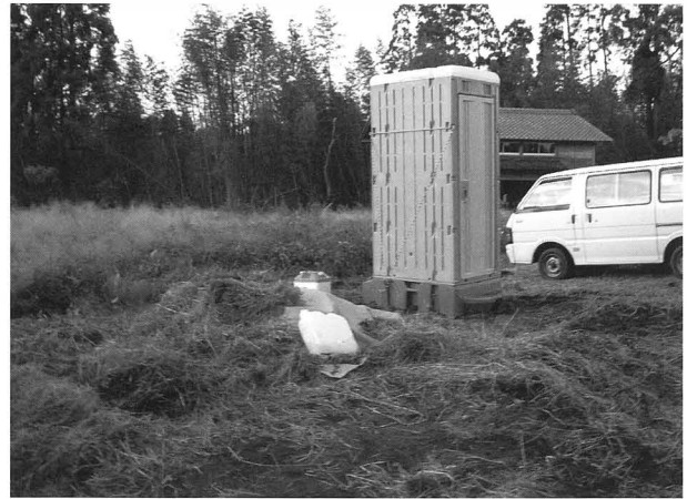
仮設トイレ設置
