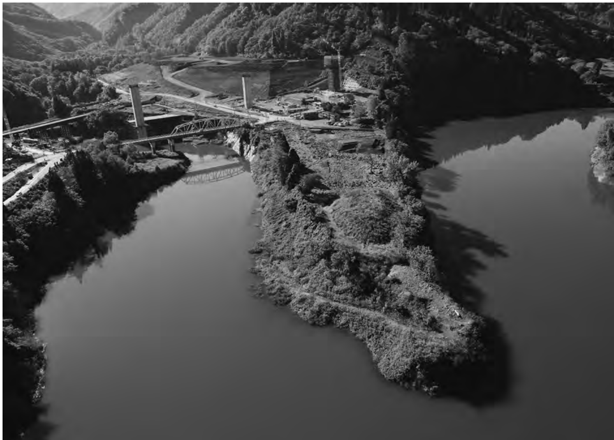
調査区全景（平成 23 年度 北から）
