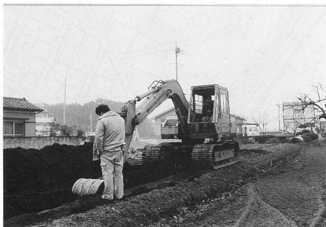
写真18 小蓋林遺跡重機による掘削
