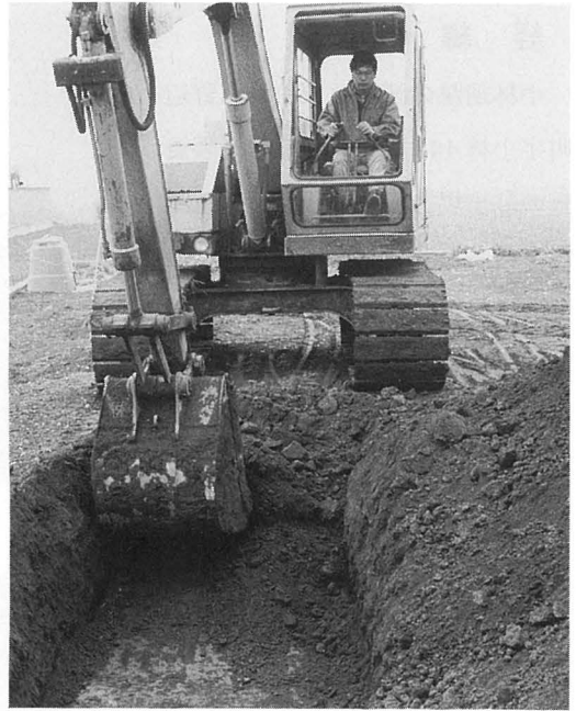
写真25 小林遺跡重機による掘削
