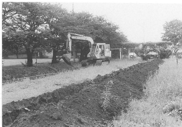
写真13 志柄1遺跡重機による掘削
