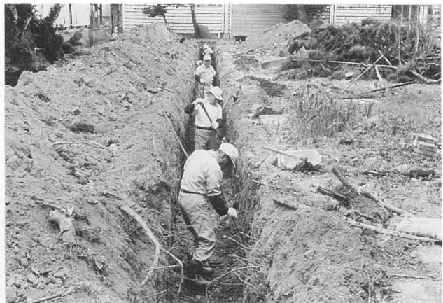
写真3 館林城跡作業風景
