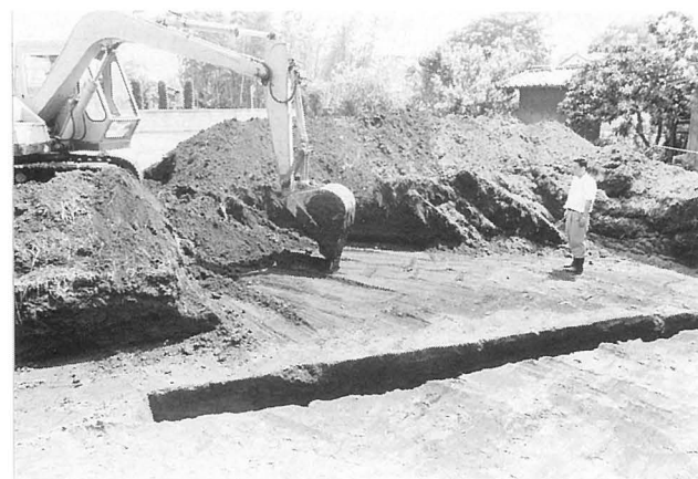
写真3 大道北遺跡 (C地点) 重機による掘削 (住居址部分)
