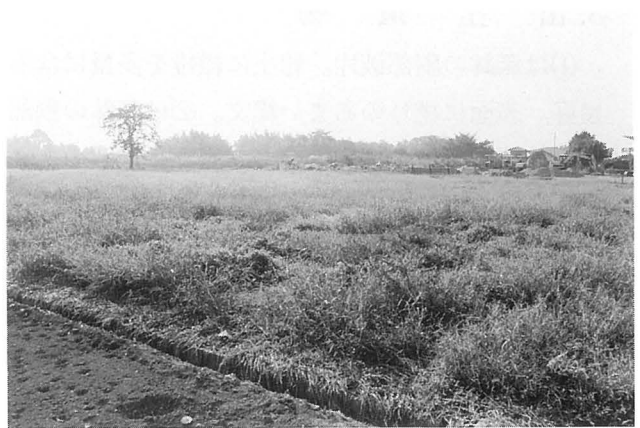
写真5 間堀2遺跡（平9地点）調査前
