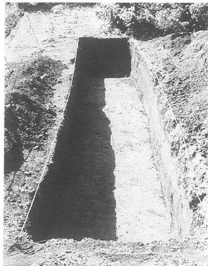
写真15 トレンチ完掘(1トレンチ)
