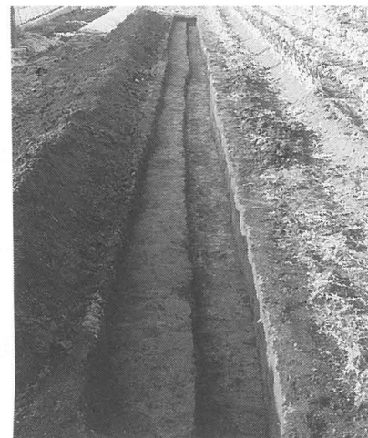
写真30 トレンチ完掘
