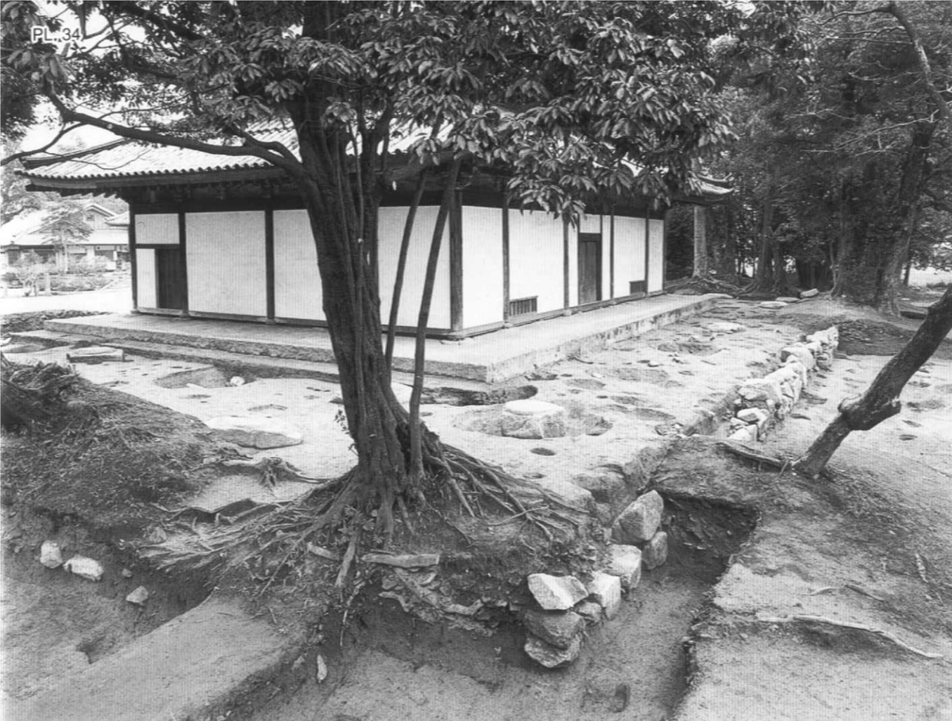
(1) 講堂 SB3800背面部 (北東から)
