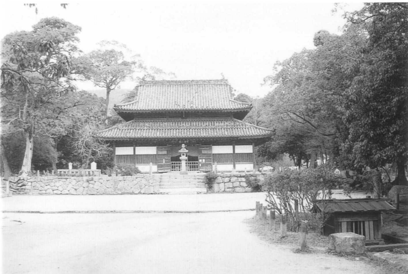
(2) 講堂建物 (元禄元年再建、南から)
