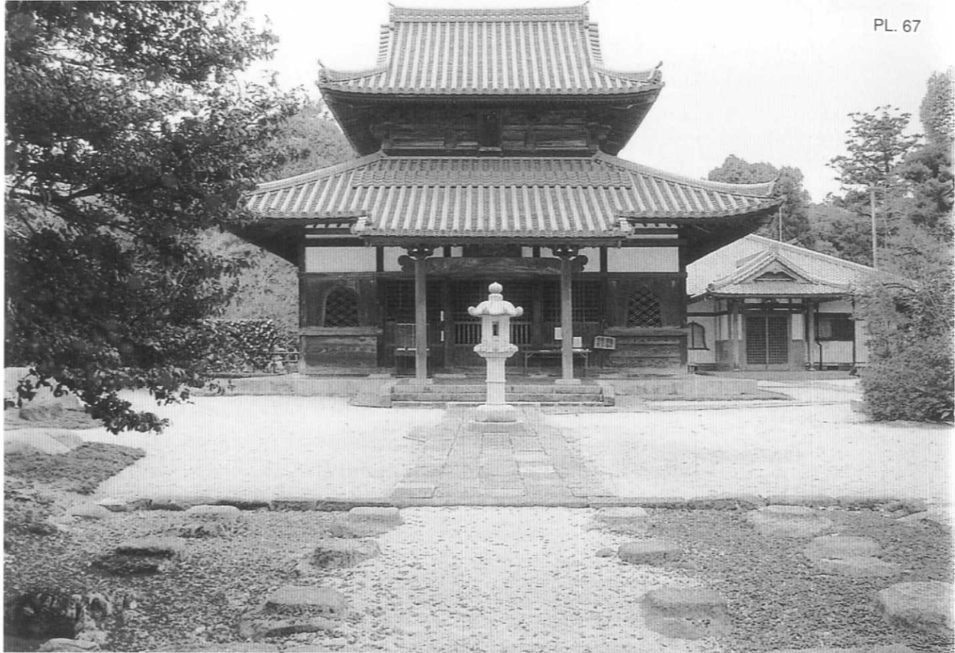
(1) 戒壇院本堂建物（寛保三年建立、南から）
