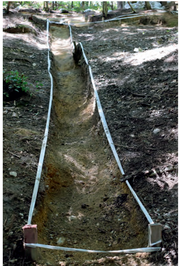
B トレンチ完掘 (南から)
