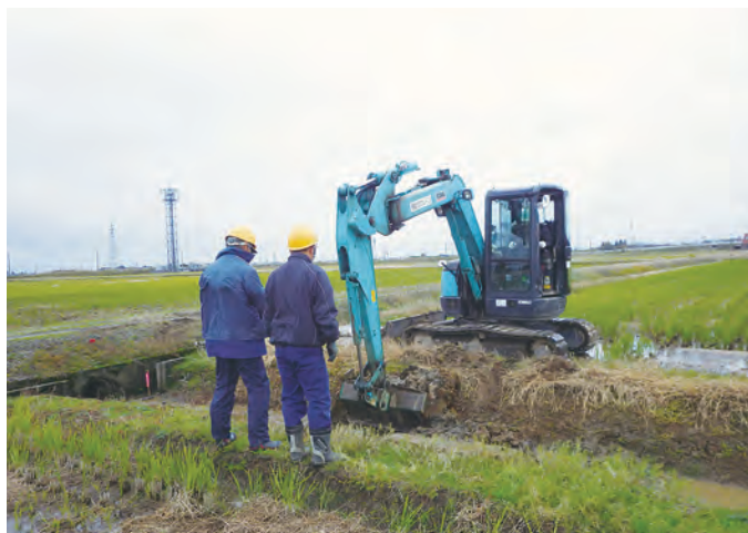
舟戸遺跡 1 トレンチ調査風景（南西から）
