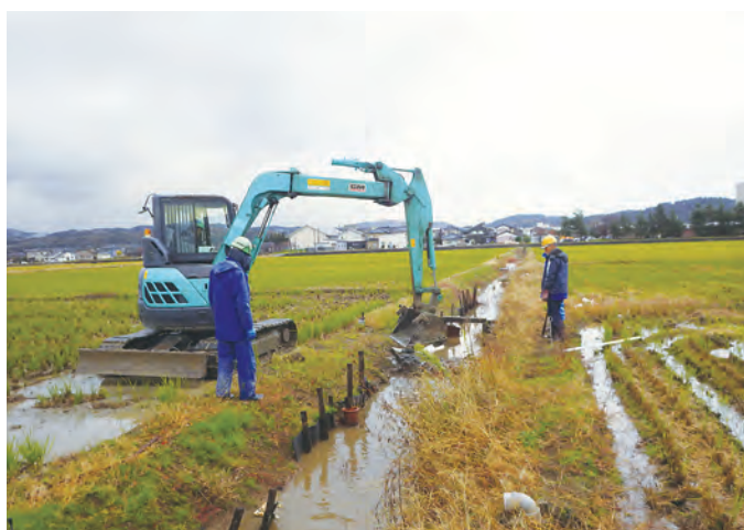
舟戸遺跡 6 トレンチ調査風景（西から）
