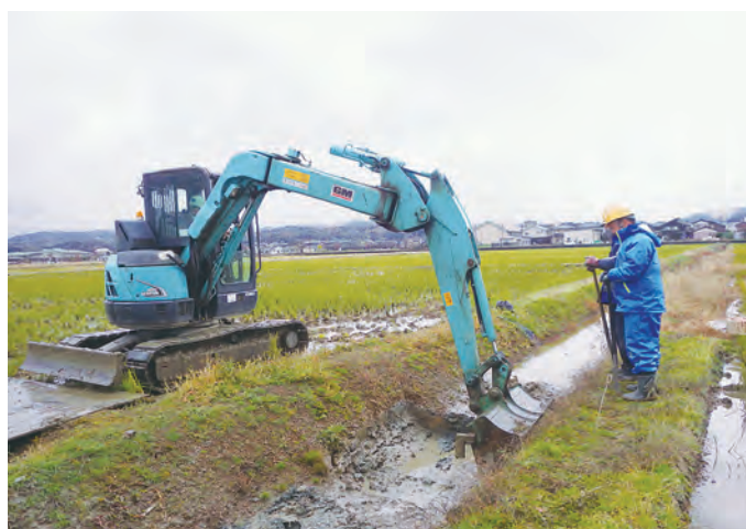
舟戸遺跡 5 トレンチ調査風景（西から）
