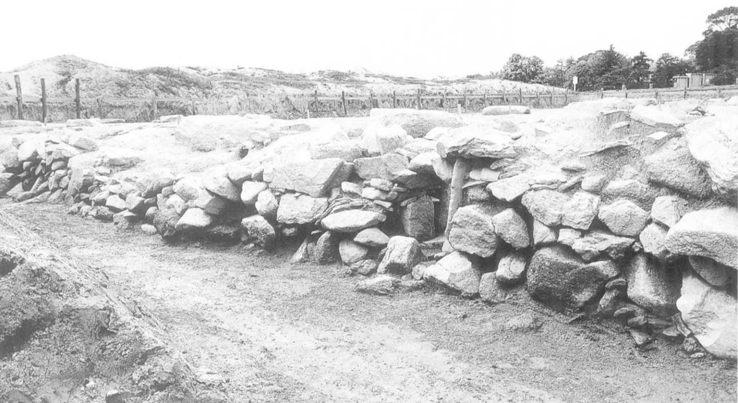
(2) 暗渠S X356吐水口周辺の石積み(北東から)
