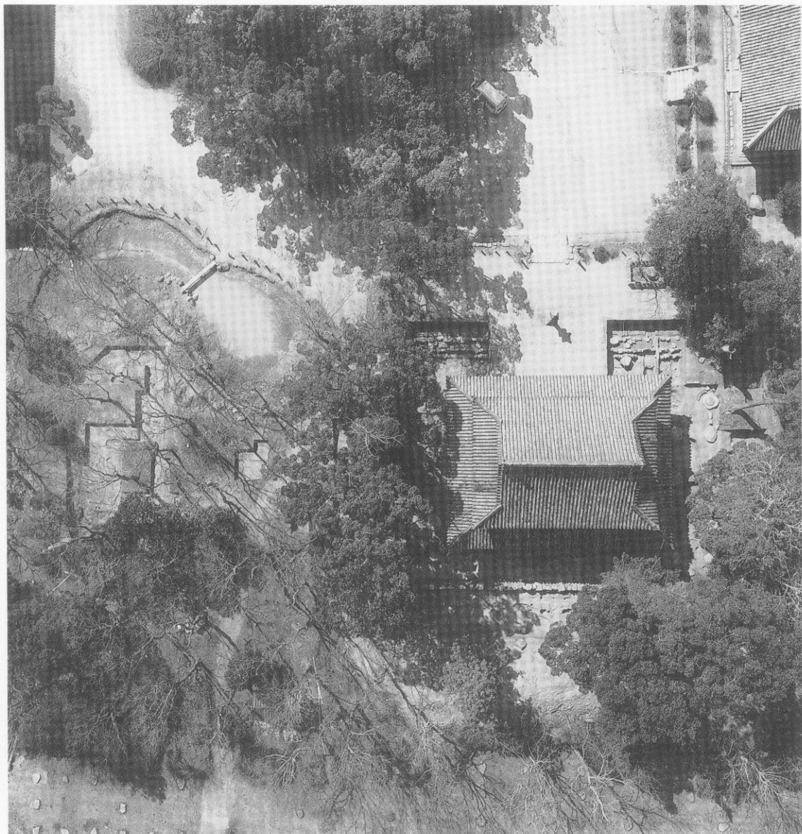
第126次調査区全景(空中写真)
