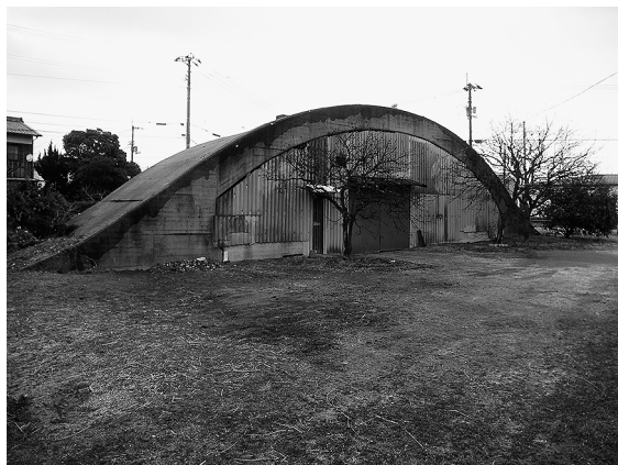
写真 1 航空機有蓋掩体全景 (南西より)
