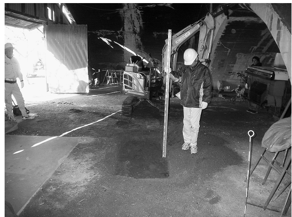
写真 2 掩体内部のトレンチ掘削状況 (東より)
