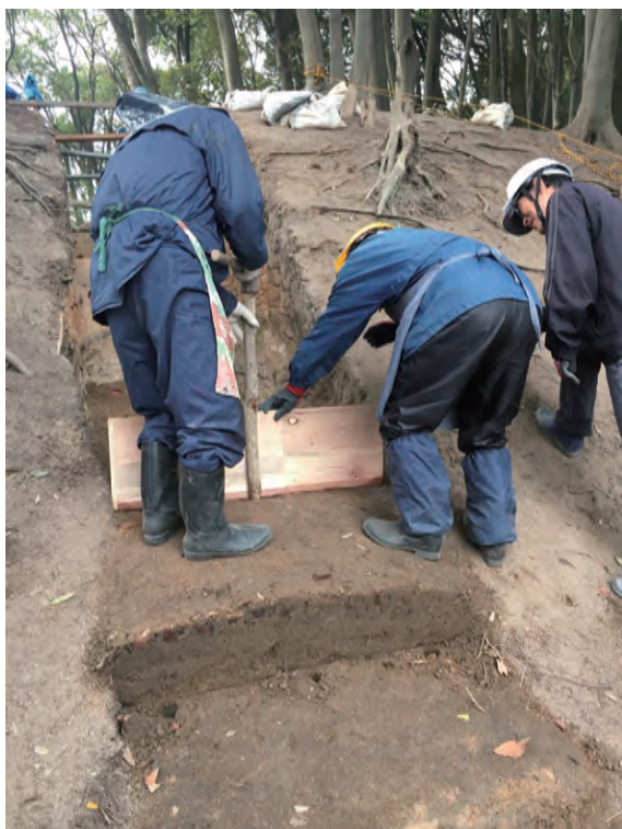
(2) 模擬版築による埋戻し 1
