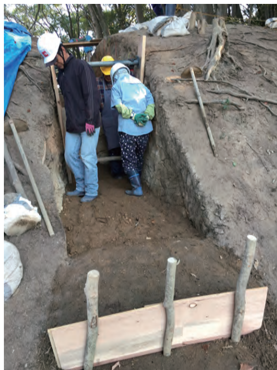
(3) 模擬版築による埋戻し 2
