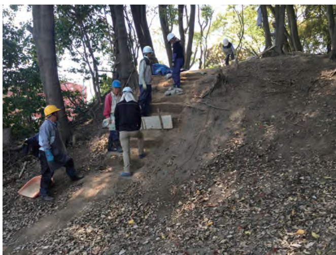
(4) 模擬版築による埋戻し 3
