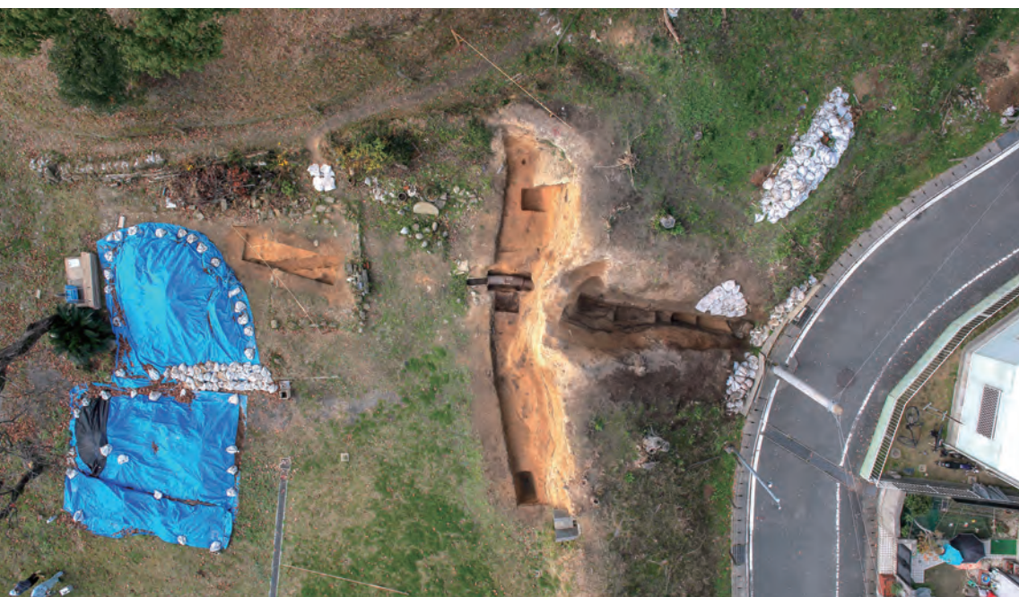
(3) 横断・縦断面 土層トレンチ箇所 (上が西)
